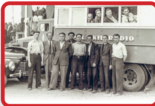
Reporterskim wozem Radia Wrocław była w początkowych latach ciężarówka z demobilu armii USA. Zamontowano na niej dwa ciężkie stacjonarne magnetofony, mieściła dwóch techników.
